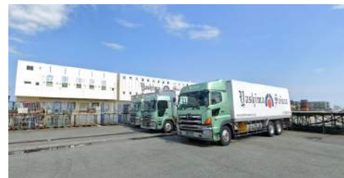
冷蔵庫団地の外観
