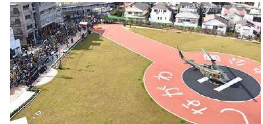
防災機能を備えた公園（品川区）
